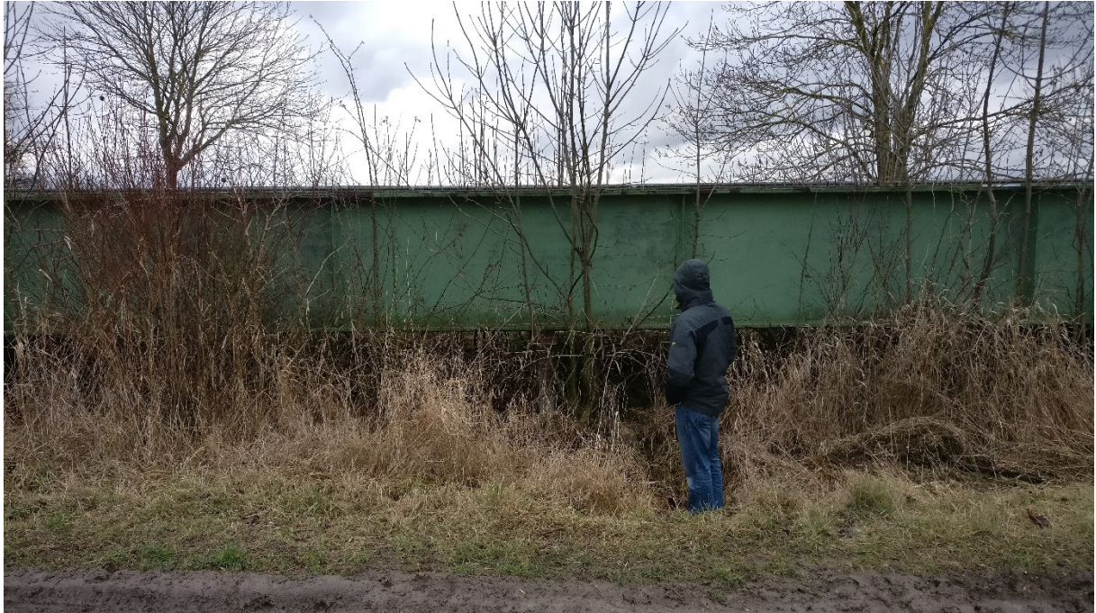
Bild 3 zugewucherter Durchlass einer Flutbrücke
