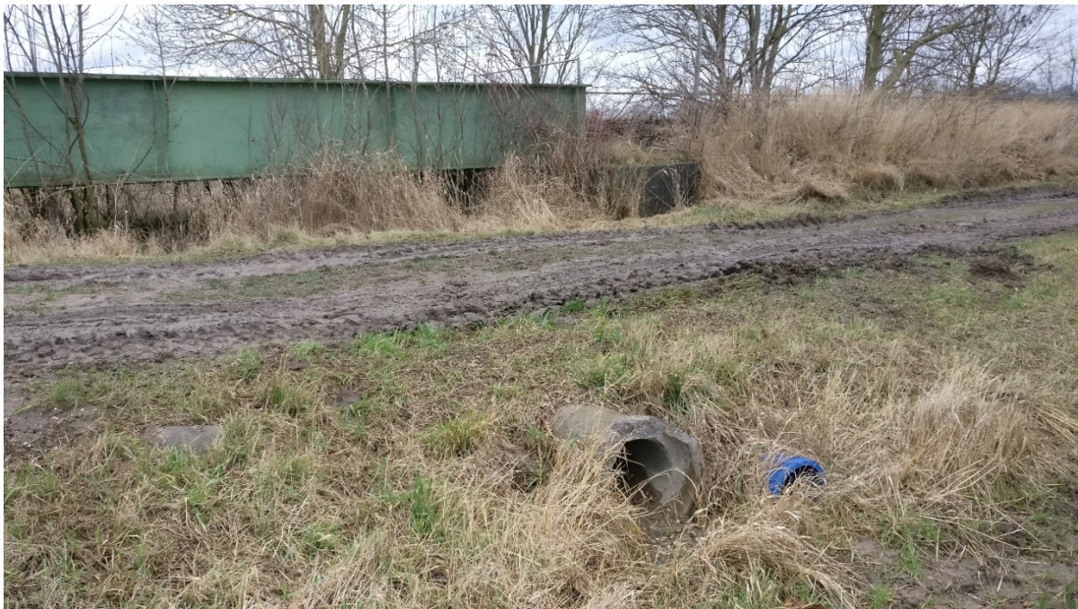
Bild 2 dammartig aufgeschüttete Baustraße vor einer Flutbrücke
